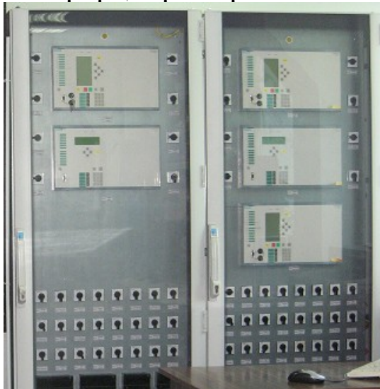
Панели микропроцессорных терминалов Сименс 7SA
